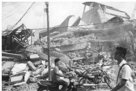
Destruction in Gunungsitoli, Nias.
